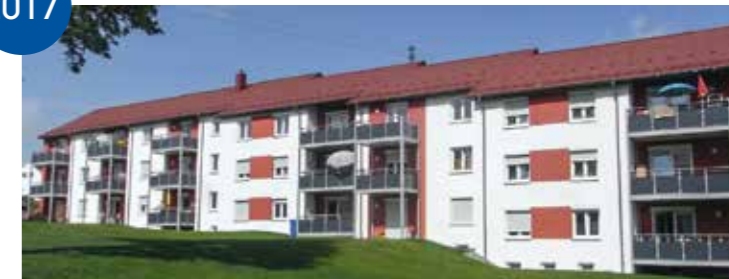
Mehrfamilienhaus, Goldrain – Baujahr ca. 1960 – Generalsanierung 2017
