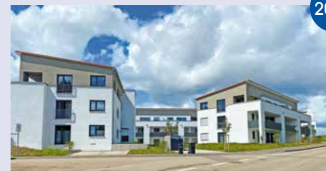
Mehrfamilienhäuser Mittelhof – Baujahr ca. 1950 – Abbruch und Neubau 2019 / 2020
