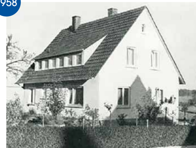
Einfamilienhaus, Braune Hardt – Baujahr 1958
