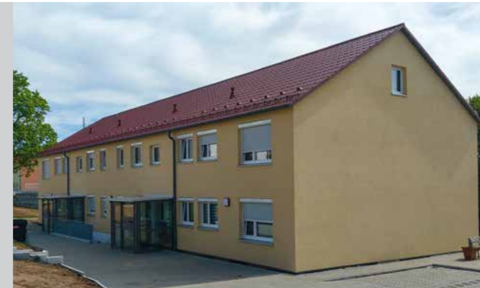
Saniertes Mehrfamilienhaus im Kolpingweg – Blick von der Straße aus
