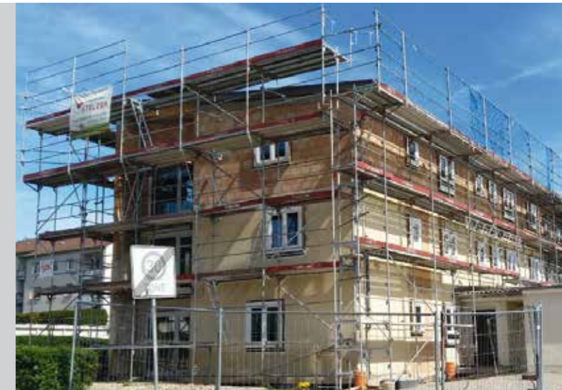
Königsberger Straße 1 a/b – Aufstockung um eine Etage
