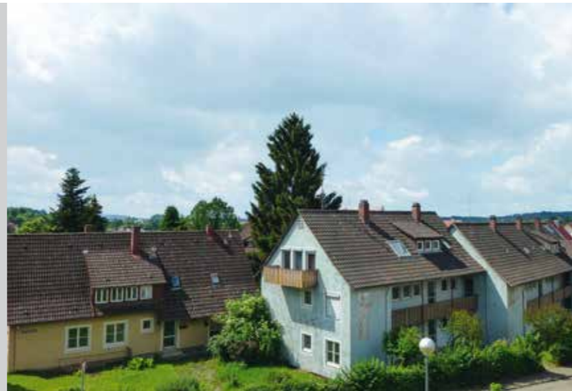
Mehrfamilienhäuser in der Abt-Kuno-Straße – vor dem Abbruch
